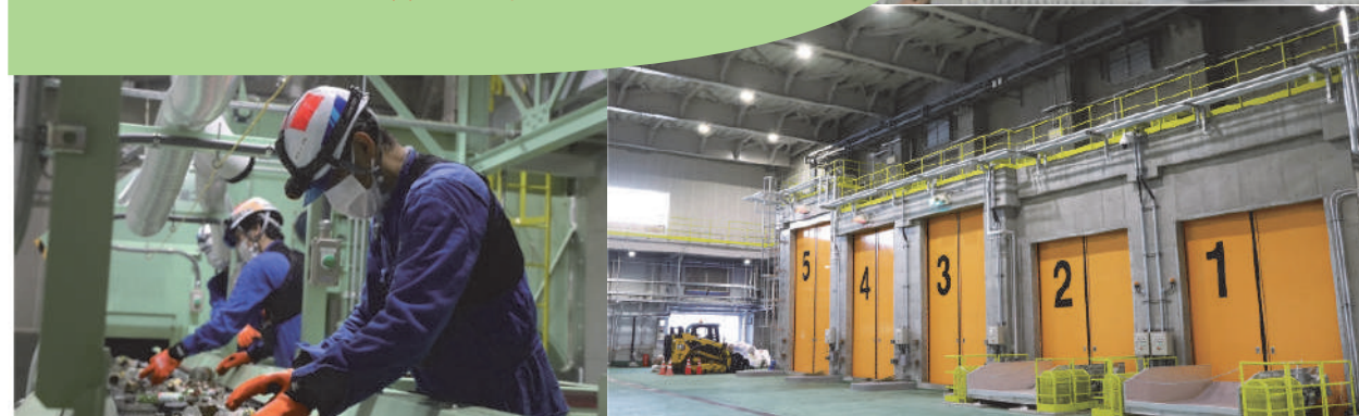
写真 左上：ごみ分別検定、右上：中央制御室（可燃）、左下：びん手選別コンベヤ、右下：プラットホーム（可燃）
