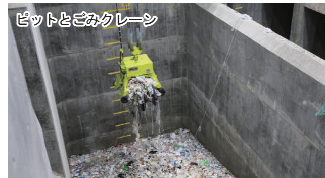
燃やすごみを約7日分貯留することが出来るピットです。搬入されたごみをごみクレーンでかき混ぜて、ごみ質を均一にします。
