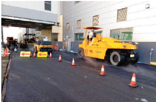
構内道路の舗装が進められています
