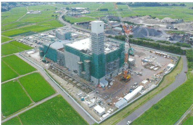
煙突が建ち上がり、外壁・屋根工事が進んでいます。（7月）
