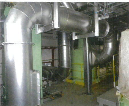
プラント内の配管工事が進められています。
