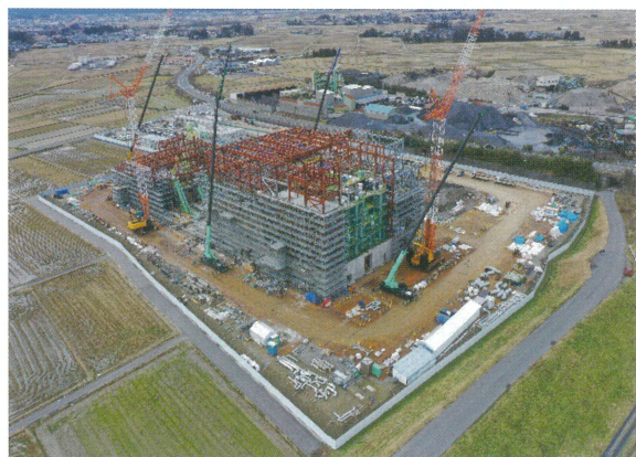
プラント機器の据え付けが進んでいます。（2月）
