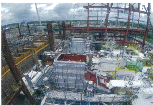
1日61t焼却できる炉が2基据え付けられました。
