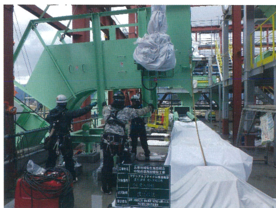
はりに接触しないよう慎重に作業しています。
