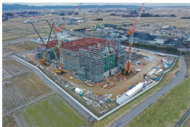
プラント機器の据え付けも進んでいます。(2月)
