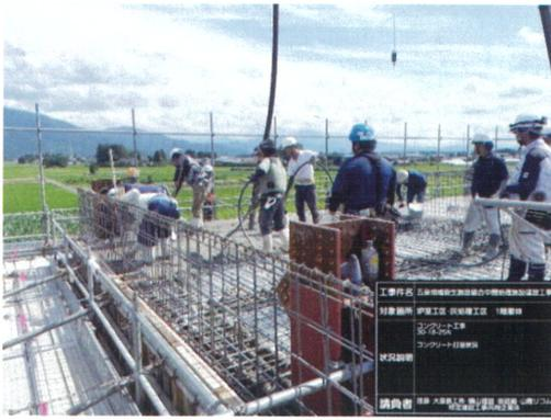
1階天井部のコンクリート打設を進めています
