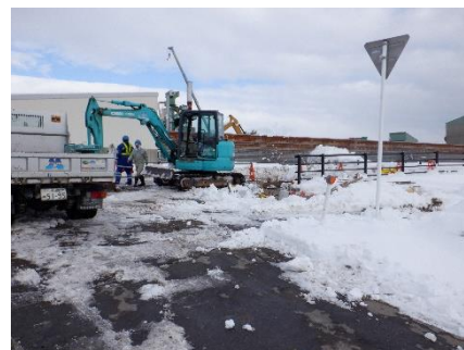
②市道側からの様子
